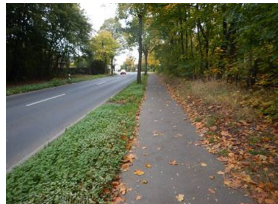
Gemeinsamer Geh- und Radweg (Zweirichtungsverkehr, zu schmal) (L472 Lengede)
