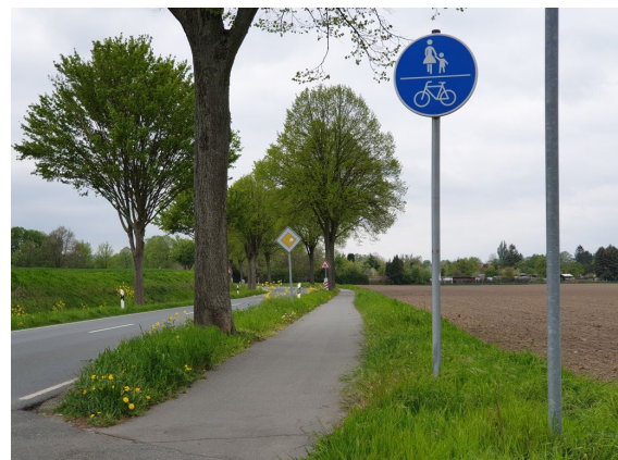
Gemeinsamer Geh- und Radweg zwischen Königslutter und Schickelsheim (L 644 Rottorfer Straße)
