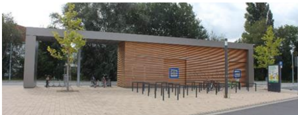
Sammelschließanlage (Bahnhof Gifhorn-Stadt)
