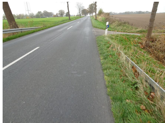
Fehlende Radverkehrsanlage (L320 Gemeinde Edemissen (außerorts))
