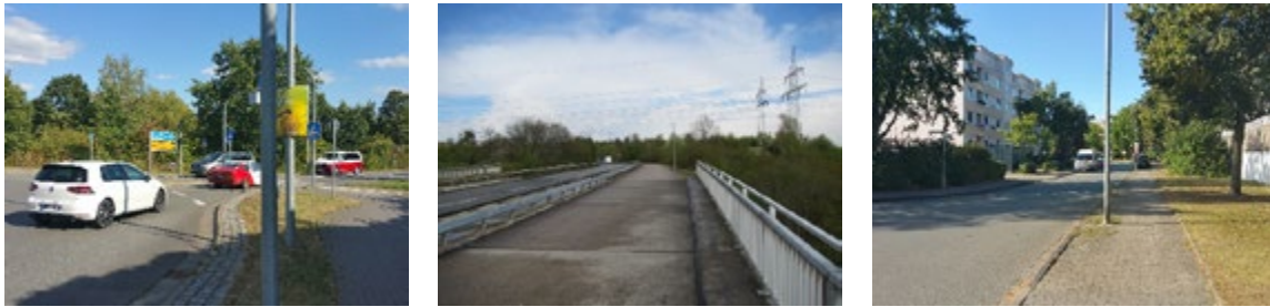
Abbildung 87: Zweirichtungsföhrung am Stralsunder Ring, Überföhrung und Stralsunder Ring als Fahrradstraße
