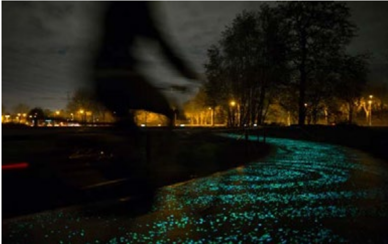
Abbildung 22: Lumineszierender Radweg (Nuenen - Eindhoven/NL)
