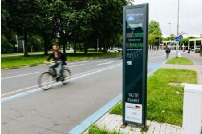
Abbildung 24: Automatische Zählstelle (eRadschnellweg Göttingen)
