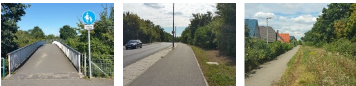
Abbildung 88: Fußgängerbrücke Frankfurter Straße, Sudetenstraße und Grünweg bei Laagberg
