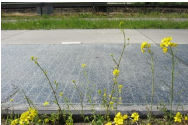
Abbildung 23: Solarstromerzeugung mit Radweg (Pilotprojekt „SolaRoad“ Zaanstad/NL)
