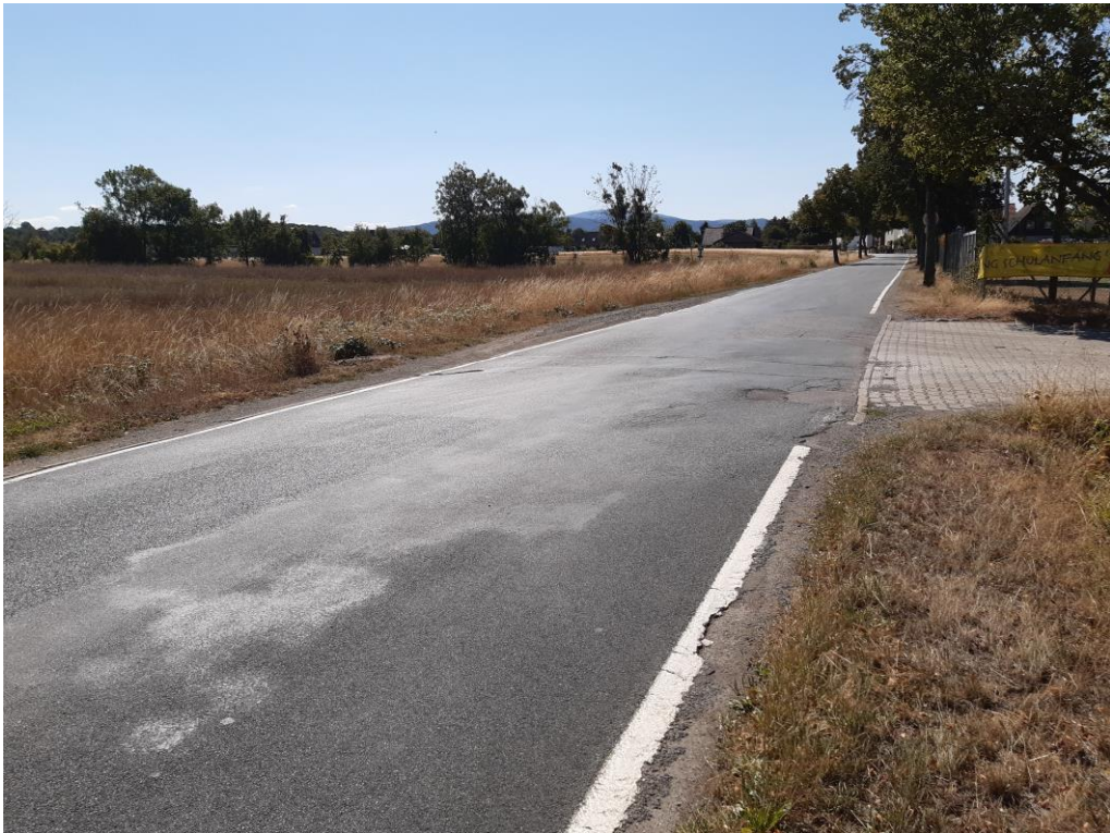
L 511 Anbindung Betonwerk
