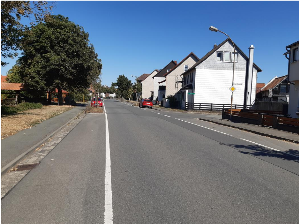
L 511, nördliche Ortsdurchfahrt Wiedelah
