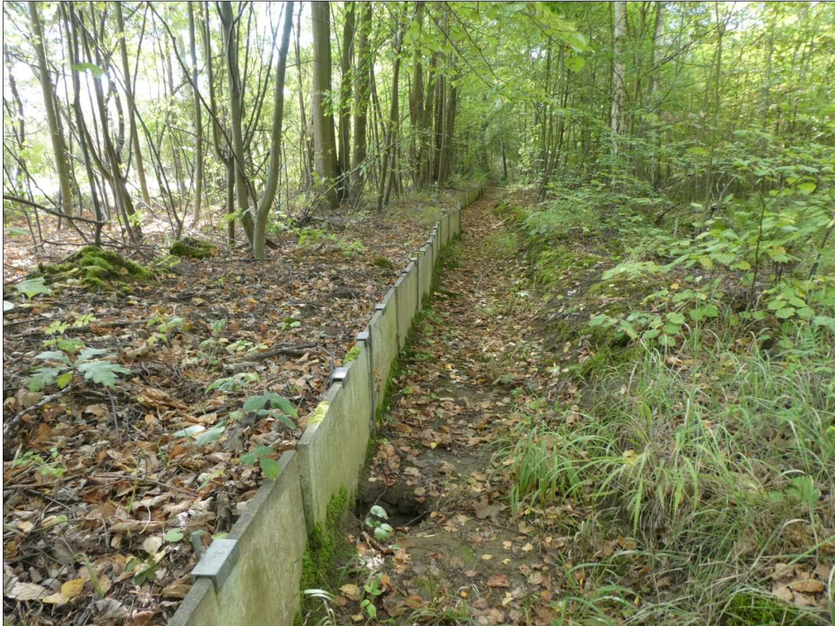
Abbildung 3.9-7: „Amphibien-Schutzzaun“ an der L 511. Aufnahme vom 21.9.2022.
