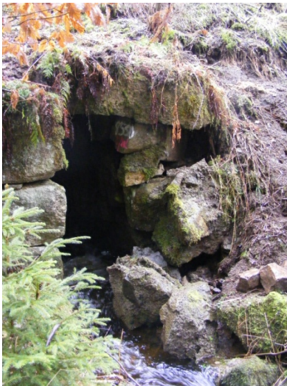
Bild 3: Beschädigung Mauerwerks mit Referenzpunkt für Wasserstandsmessung
