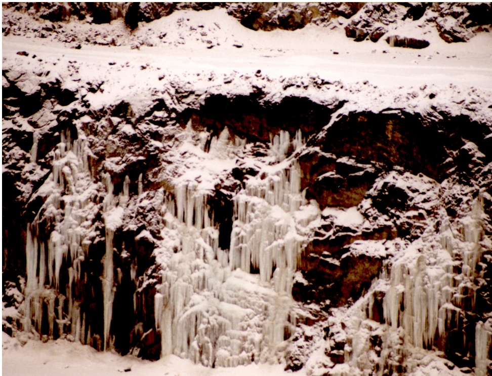
Abb. 2. Austretendes Kluftwasser; Nordwand, 3. Sohle des Abbaus
